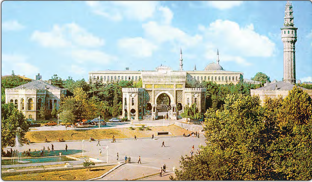
Görsel 6: Lozan Antlaşması'ndan sonra dârülfununa tahsis edilen ve hâlen İstanbul Üniversitesi merkez binası olan eski Harbiye Nezareti.
